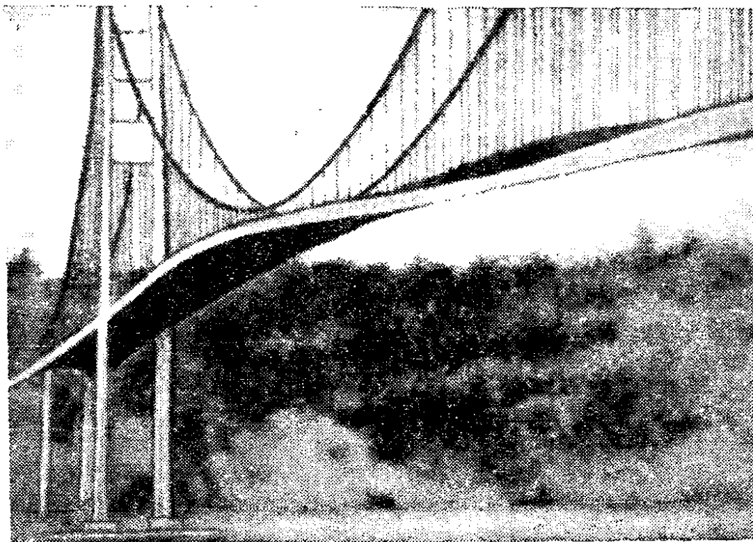
Рис. 2. Колебания проезжей части Тако́мского моста за час перед катастрофой
